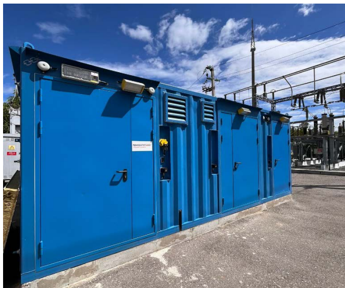
Рис. 1. Автономная водородная заправочная станция КГЭУ
